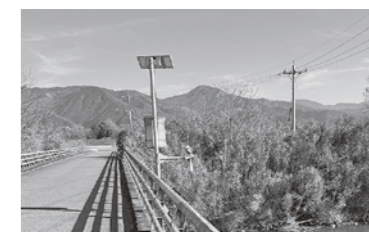
設置予定の監視カメラ
