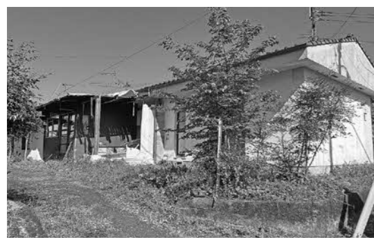
解体が急がれる町営住宅
