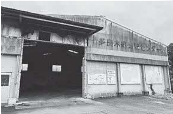
老朽化が進む堆肥センター
