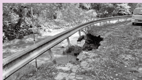
永原線災害復旧工事現場
