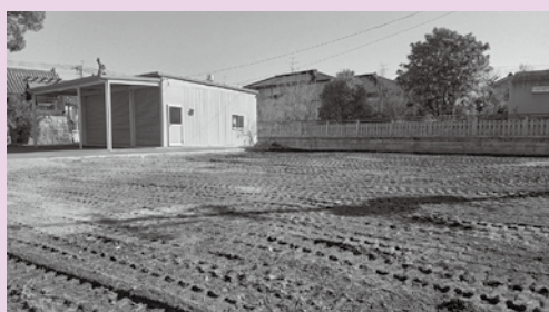
備蓄倉庫の建設予定地
