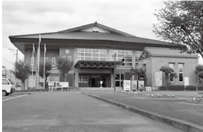
エアコン設置が望まれる避難所
