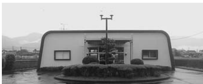
老朽化した多良木火葬場
