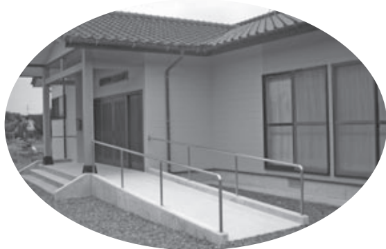
改修された多10-2公民分館
