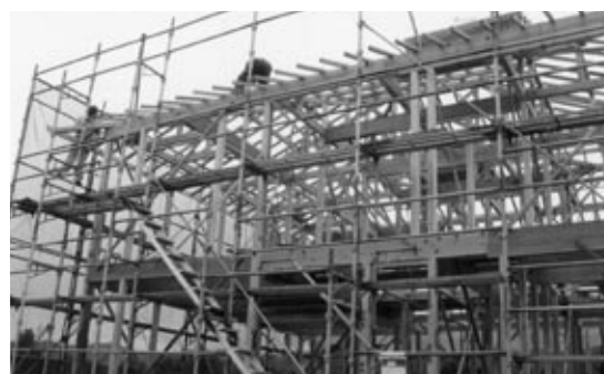
新築中の住宅
