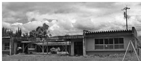
老朽化した久米学童施設
