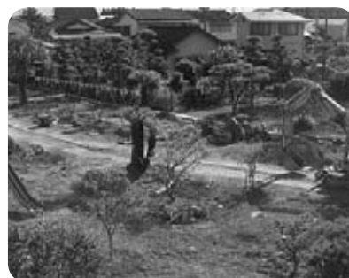
多良木小学校屋外整備工事
