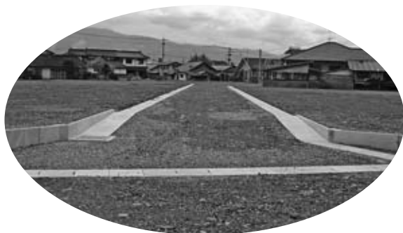
造成が進む 小林第2団地
