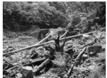
久米川内川被災現場
