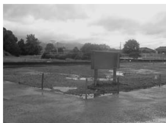
黒肥地小学校屋内運動場改築工事現場
