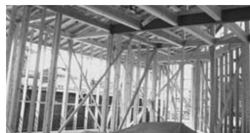
木材をふんだんに利用した新築現場
