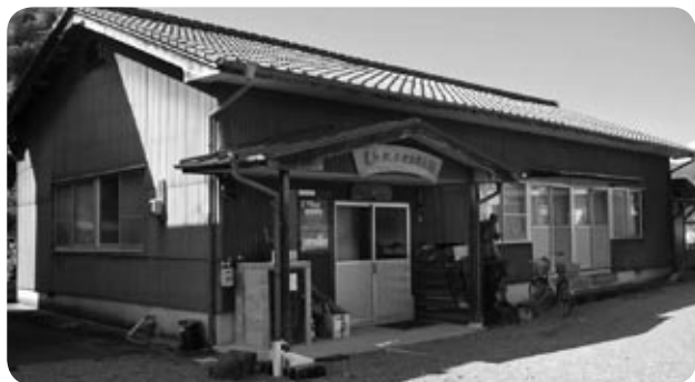
改修される黒肥地3区公民館
