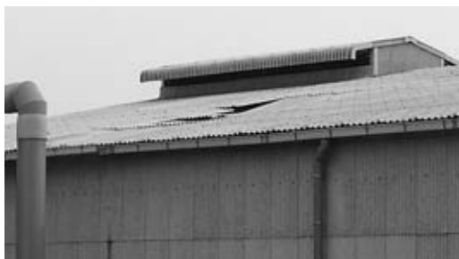
大規模改修現場
