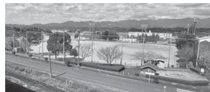
広大な敷地を広域防災拠点に !!
