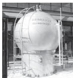
災害用給水タンク
