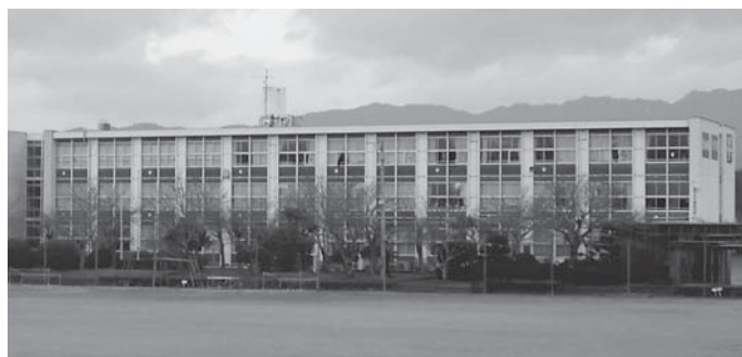
耐力度調査を実施した中学校校舎
