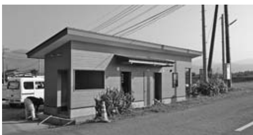
建設中の公衆トイレ（黒肥地）
