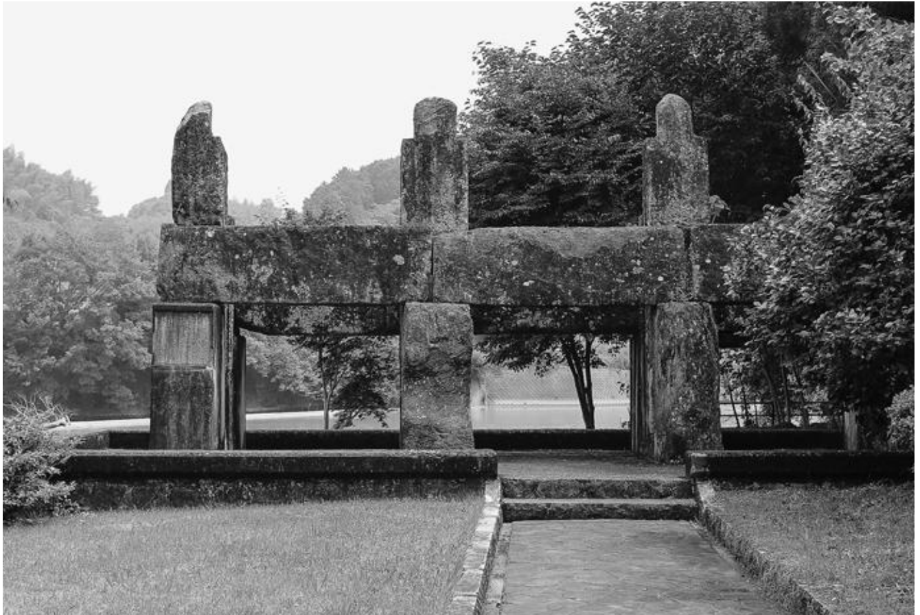
町指定文化財 百太郎溝取入口旧樋門
