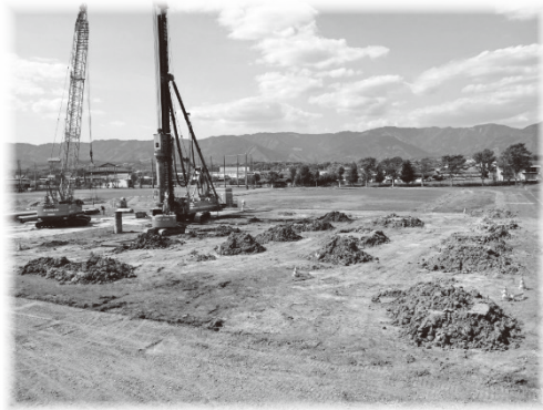
【杭工事状況(4月)】
