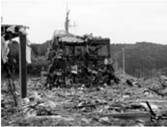
南三陸町 防災センター
