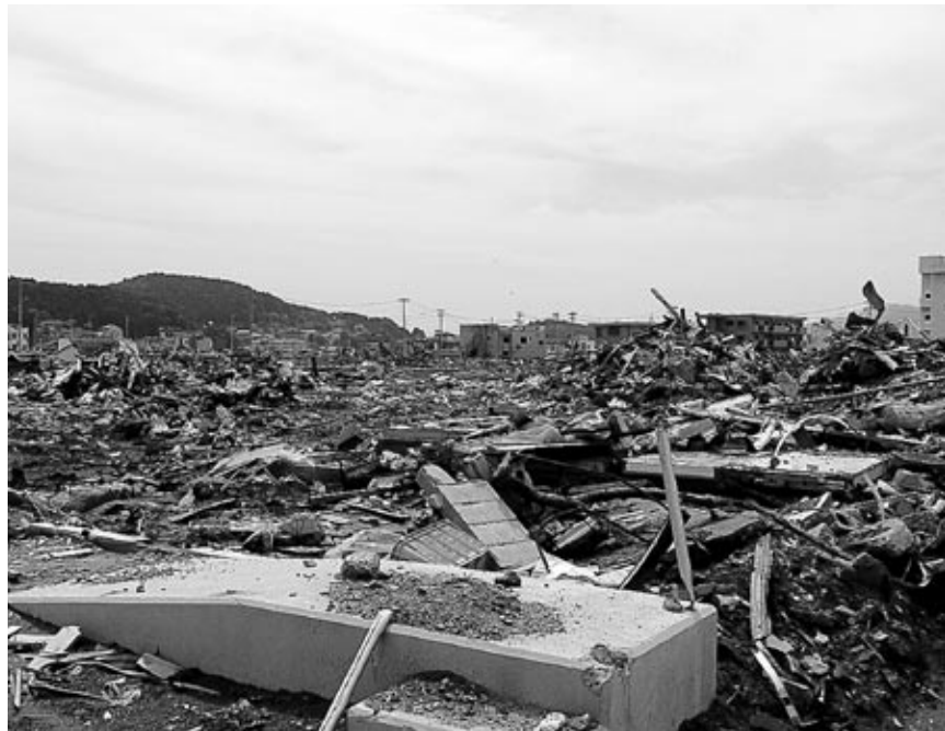
南三陸町の津波被害状況
