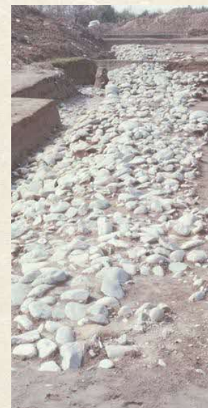
石積堤防の様子
