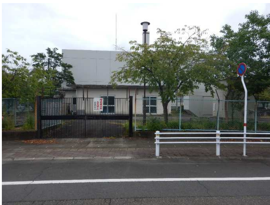
【 送水ポンプ所及び第6水源 】
